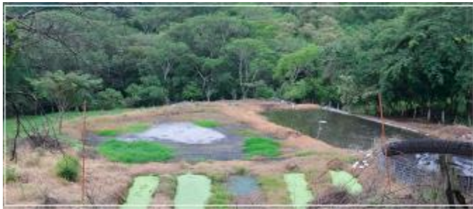
Ilustración 8 laguna de oxidación, PTAR, sedimentación, purificación
