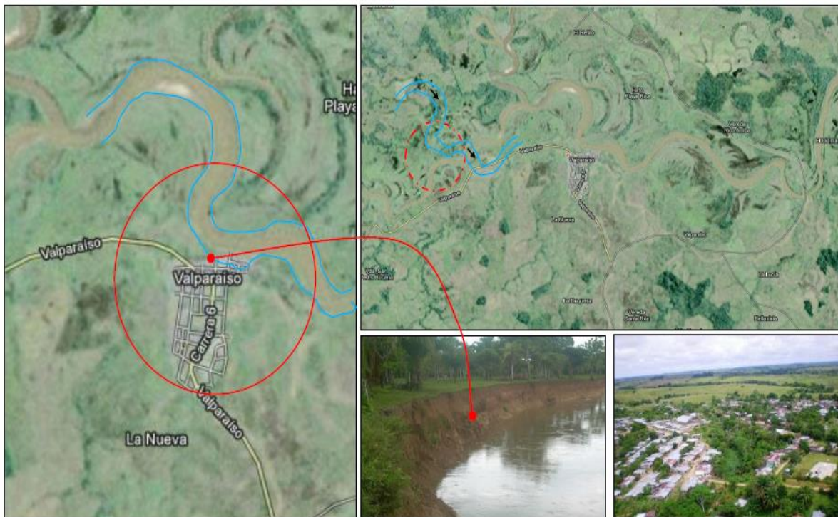
Figura 77. Socavación lateral del río Pescado en el municipio de Valparaíso
